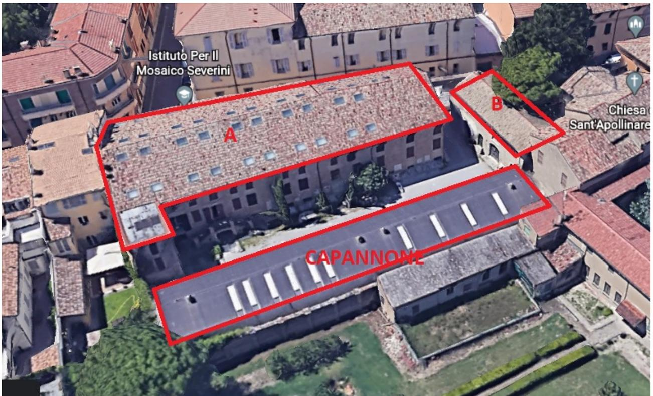
Il "Corpo A" è articolato in due piani completamente fuori terra ed un piano parzialmente interrato, i solai sono realizzati in latero cemento, non sono stati riscontrati cordoli di piano o altri sistemi di ritegno e collegamento dei maschi murari. La copertura è di tipo pesante.
